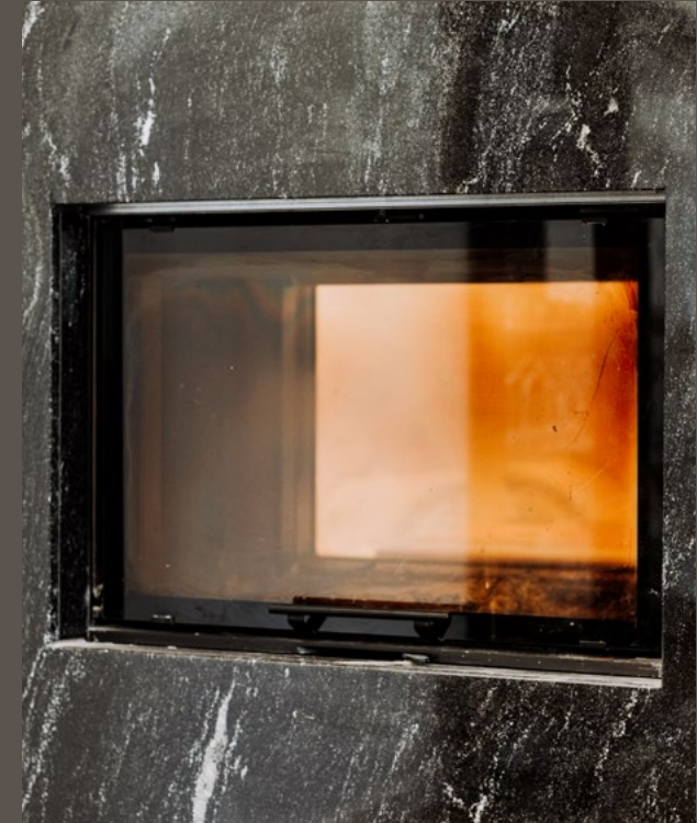
Durchsicht-Kamin mit Marmor-Fassade
